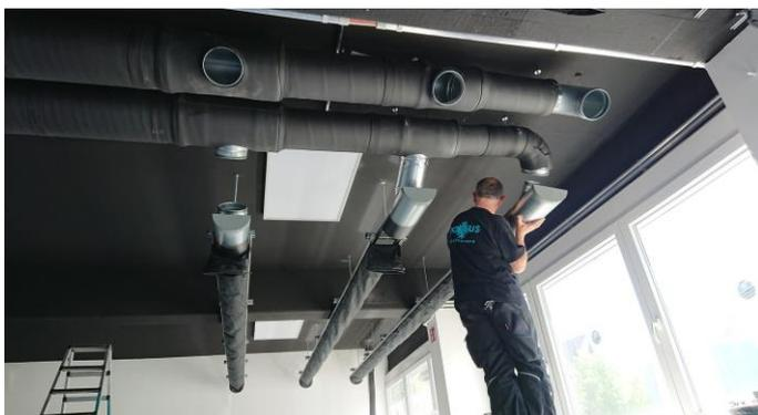
das Objekt soll im Sommer und im Winter zugfrei auf 23°C gehalten werden. Bei einer Inneren Last von 32 kW ist das schon ein Wort. Im Bürobereich haben wir ca 8 kW abzukühlen oder aufzuheizen. Und das zugfrei bei einer Deckenhöhe von 230 cm. Das gibt eine Herausforderung. Diese Leistung ist nur mit Luftverteiler zu bewältigen. Nach einigen Berechnungen stand fest. Mit einer Länge von 30 m Schlauch ist die Luftmenge, die eingesetzt werden muss, zu verteilen.
